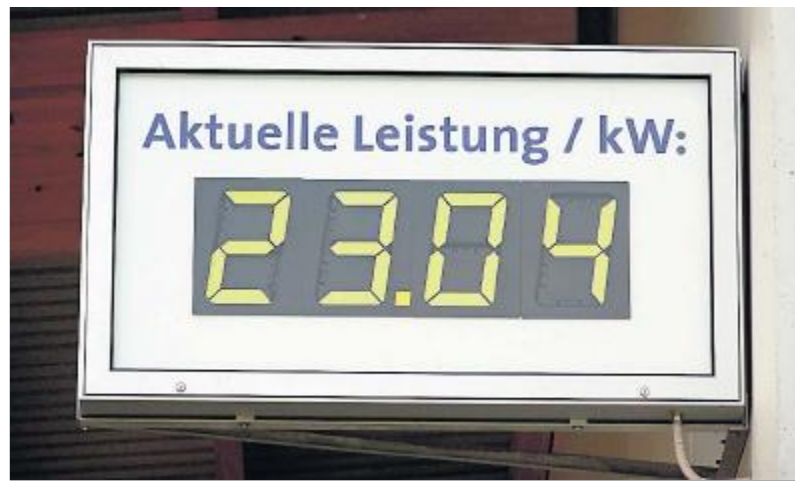
MEHR STROM PRODUZIERT ALS ERRECHNET Anzeige der Photovoltaikanlage beim Werkhof in Gipf-Oberfrick mit der aktuellen Leistung. CHR
